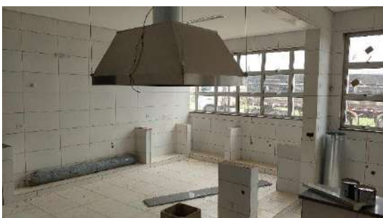
Cozinha com bancadas pendentes de fixação.
