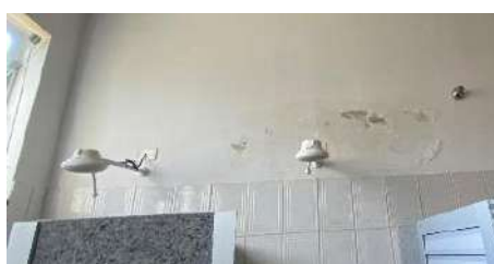
Paredes do banheiro dos alunos com sinais de infiltração.
